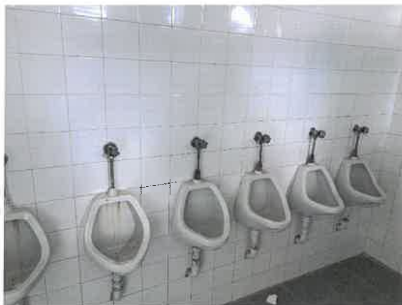
Fotografia 5 – Mictórios com torneiras não temporizadas
