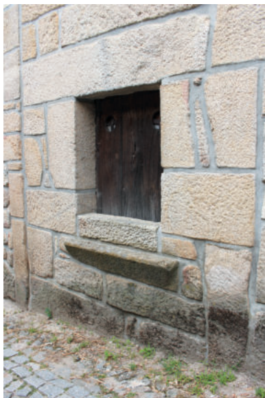
Janela viária. Desenho da estrutura original, liberto de um parapeito entretanto sobreposto na plataforma de atendimento
